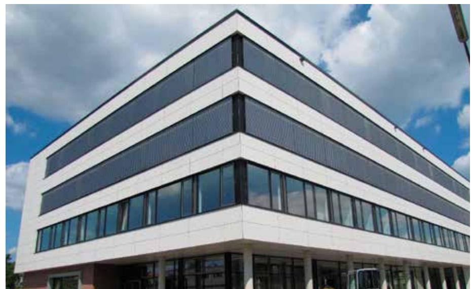
Neuer Raum für IT-Fachkräfte: Im Erdgeschoss der EDV-Schulen befinden sich u.a. die Aula und ein Vortragssaal. In der ersten Etage ist die Verwaltung untergebracht, im zweiten und dritten Geschoss je sieben topmoderne IT-Fachräume.
